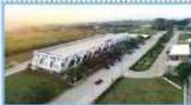
Kategori Penghimpunan Pongokolin Target berdasar dari Rute/Jalan (TR) Tipe B Pongokolin TR KM 66-200 Jalan B Jalan Tol Purwokerto-Malang PT. JasaMarga Purwokerto-Malang - Tolok 2
