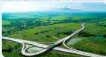
Kategori Pengembangan Tol/leak Jalan Tol Panjang > 100 KM Ruang Nyaon-Koror PT Jasa Marga Nyaon Koror Koror - Puncak 2
